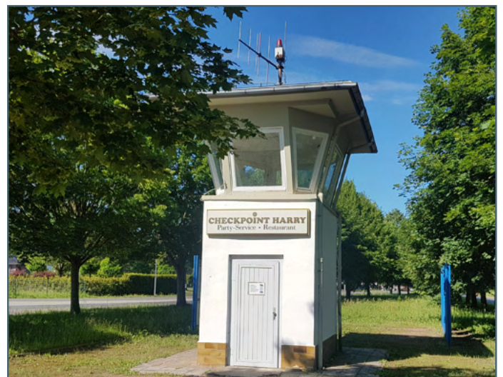
Beobachtungsturm des ehemaligen „Transitkontrollpunktes Vier“ in Boizenburg. Heute Bestandteil einer Freiluftausstellung zur Geschichte der innerdeutschen Grenze und Werbefläche des benachbarten Imbisses. (Foto: IDD)
